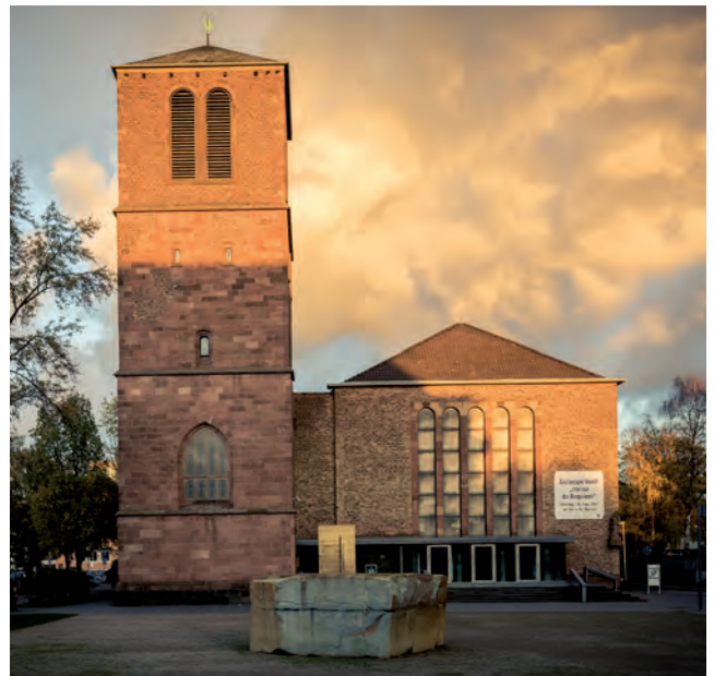
Die Marienkirche in Düren bildet eine Symbiose aus Gotteshaus, Gemeinde- und Bildungsraum.
